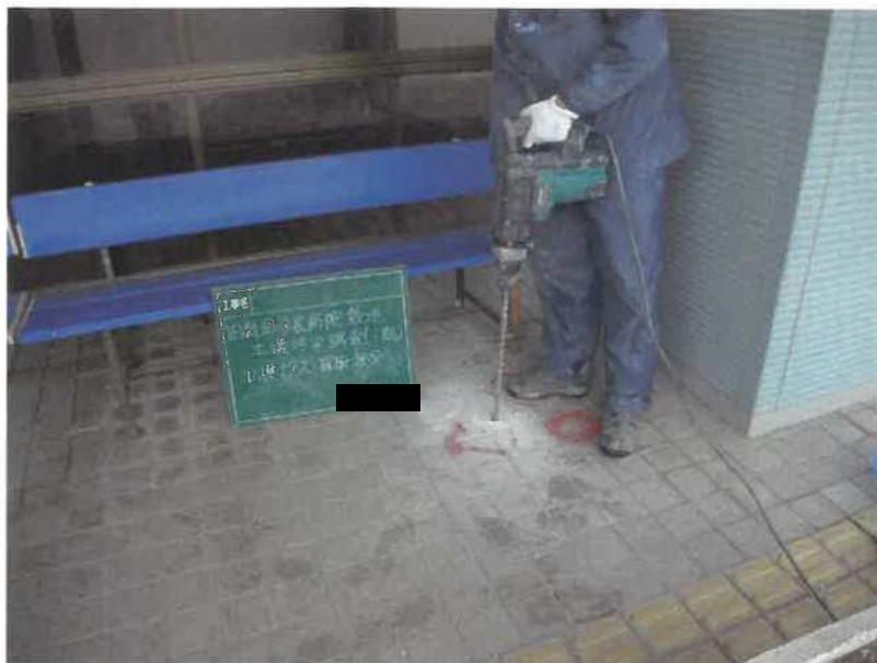
ハンマードリル による穿孔
