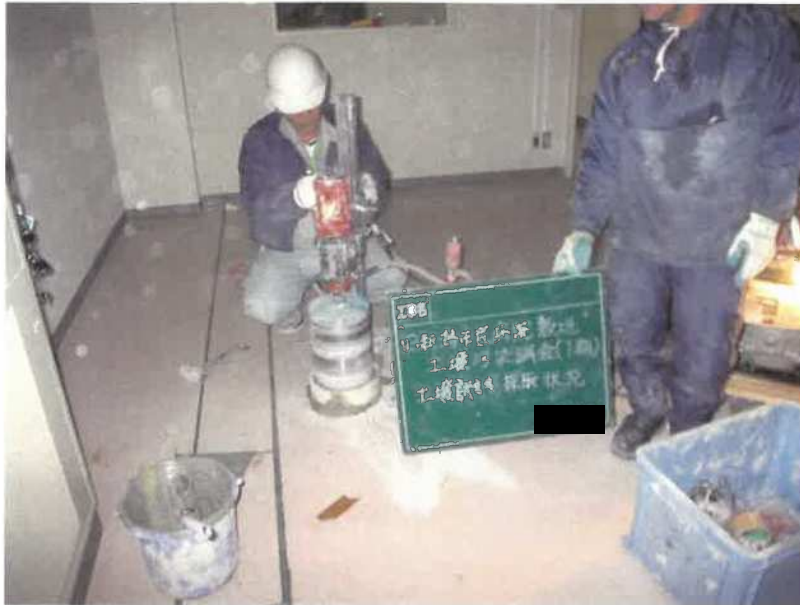
コアカッターによる コンクリート穿孔
