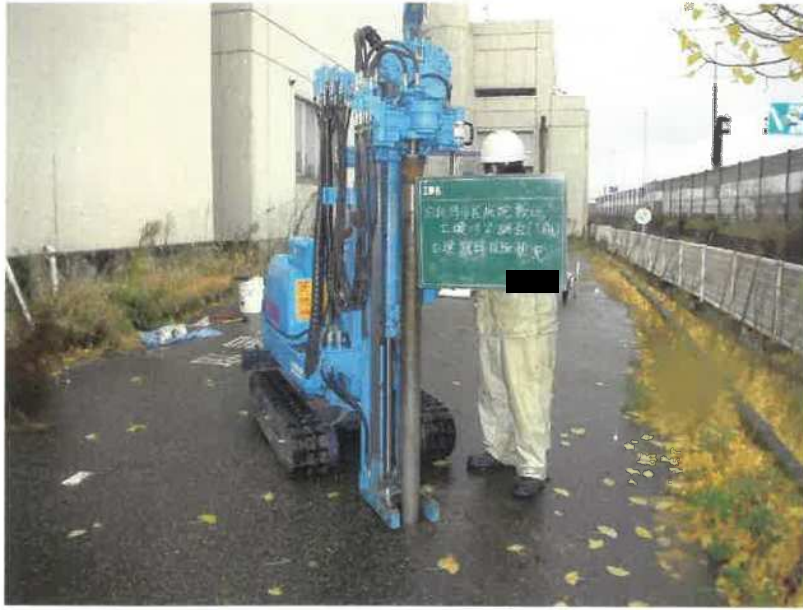
簡易ボーリング による掘削
