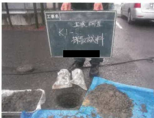
図3.7 人力による土壌試料採取
